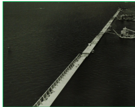
高潮防波堤 昭和39年(1964年)完成
